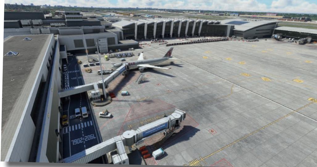
Der „Connector“ in der Bildmitte verbindet die beiden Concourse miteinander.
