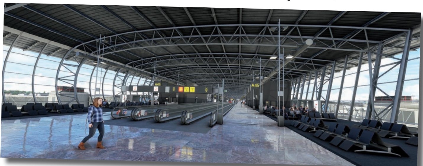
Das Innere des nördlichen Concourses mit animierten Rolltreppen für die schnelle Fortbewegung in dem sehr langen Gebäude.
