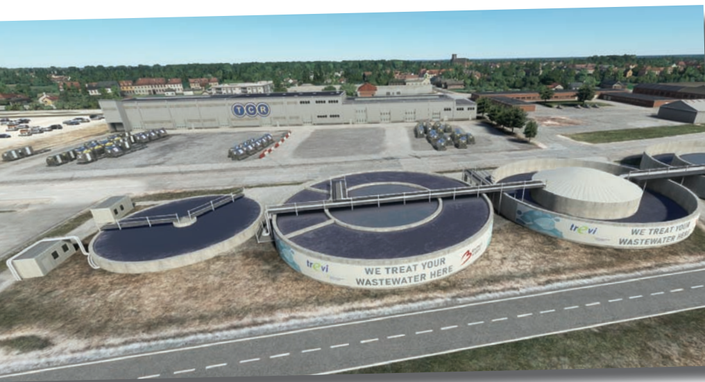
Brüssel-Zaventem verfügt über eine eigene Abwasser-Kläranlage.
