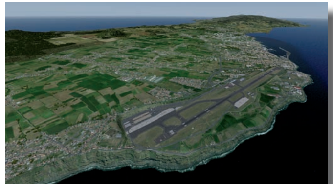
Übersicht des Airports nach Norden.
